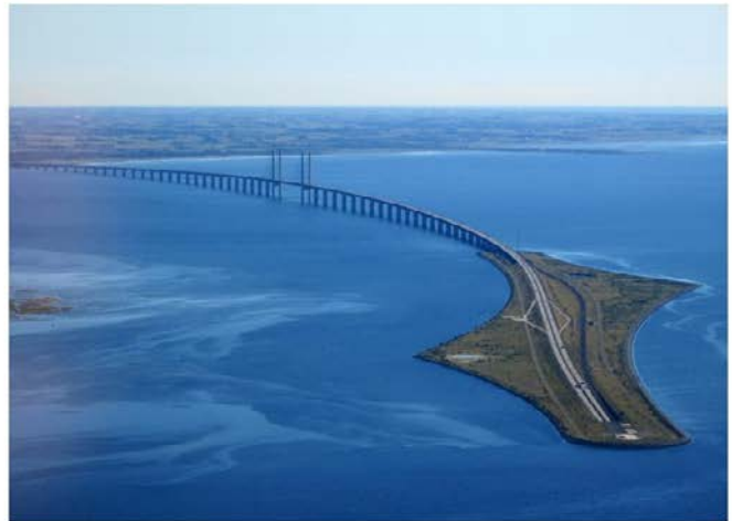
Öresund Link on kiinteä liikenneyhteys Juulinrauman salmen yli Ruotsin ja Tanskan välillä. Se muodostuu sillasta, tekoasaaresta ja tunnelista.
